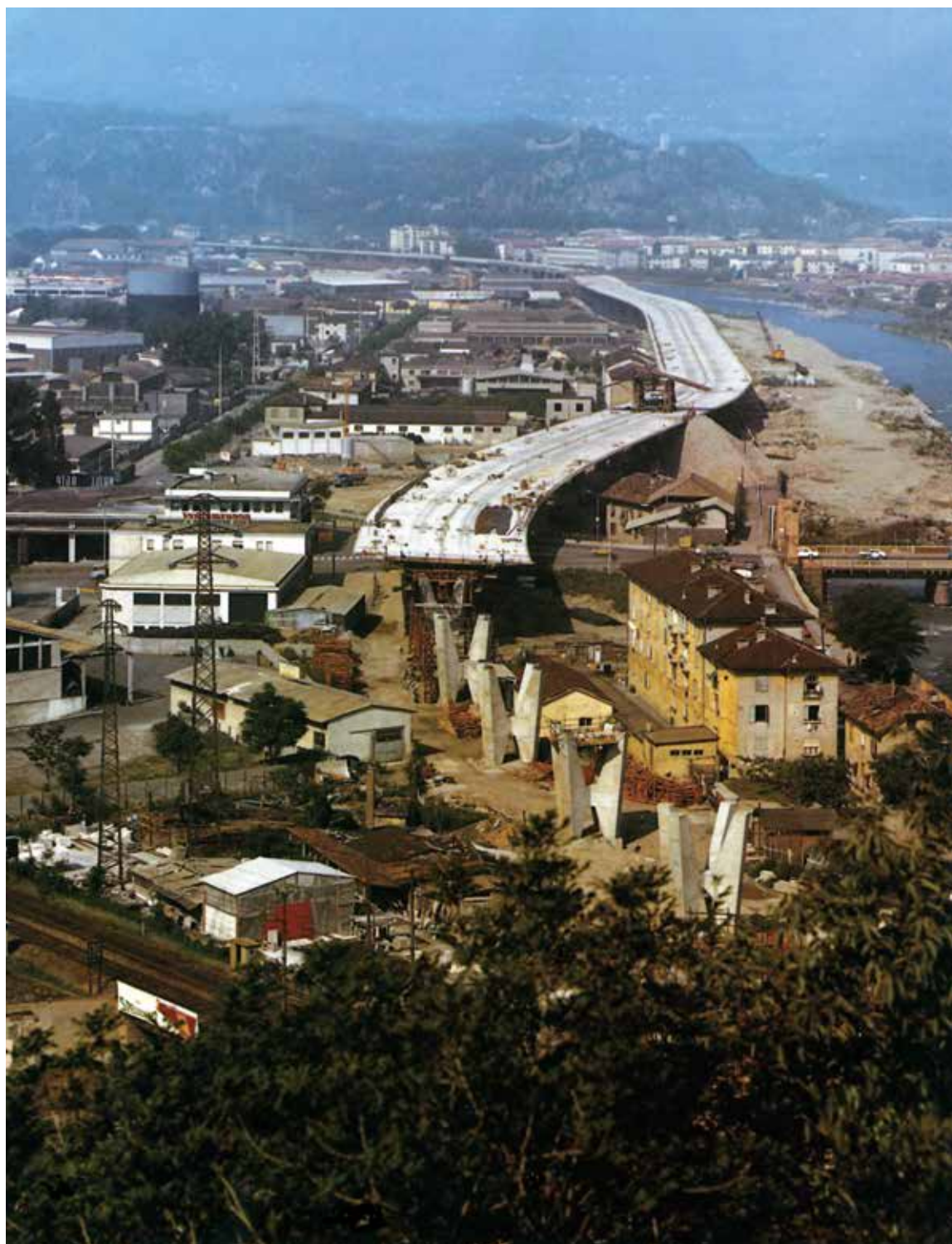
Attraversamento della città di Bolzano: Viadotto in costruzione.
