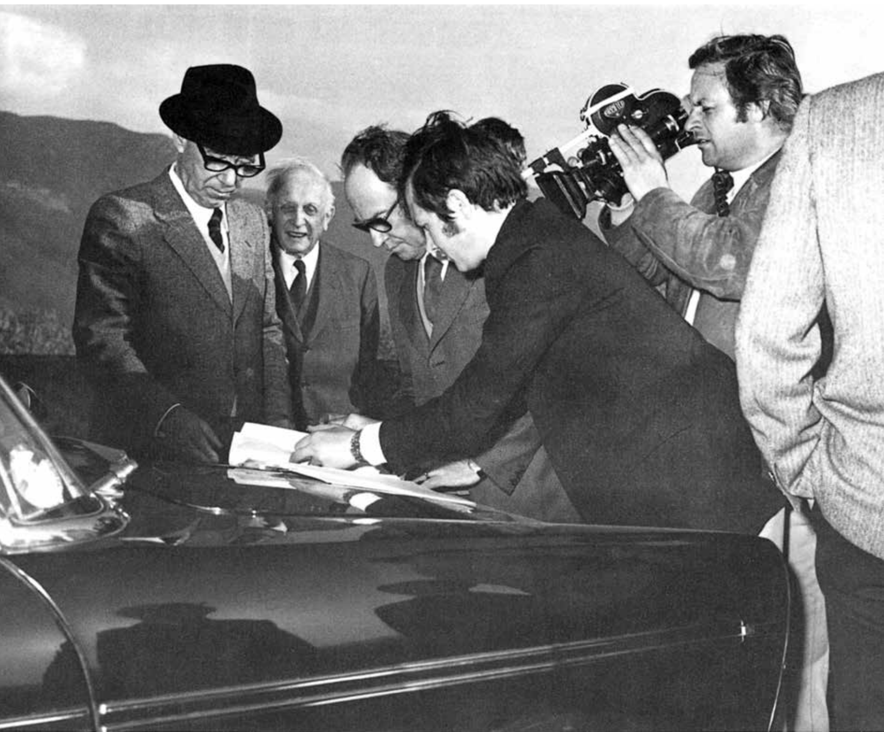
Bolzano, 11 aprile 1974. Firma verbale apertura al traffico di tutta l'autostrada.
