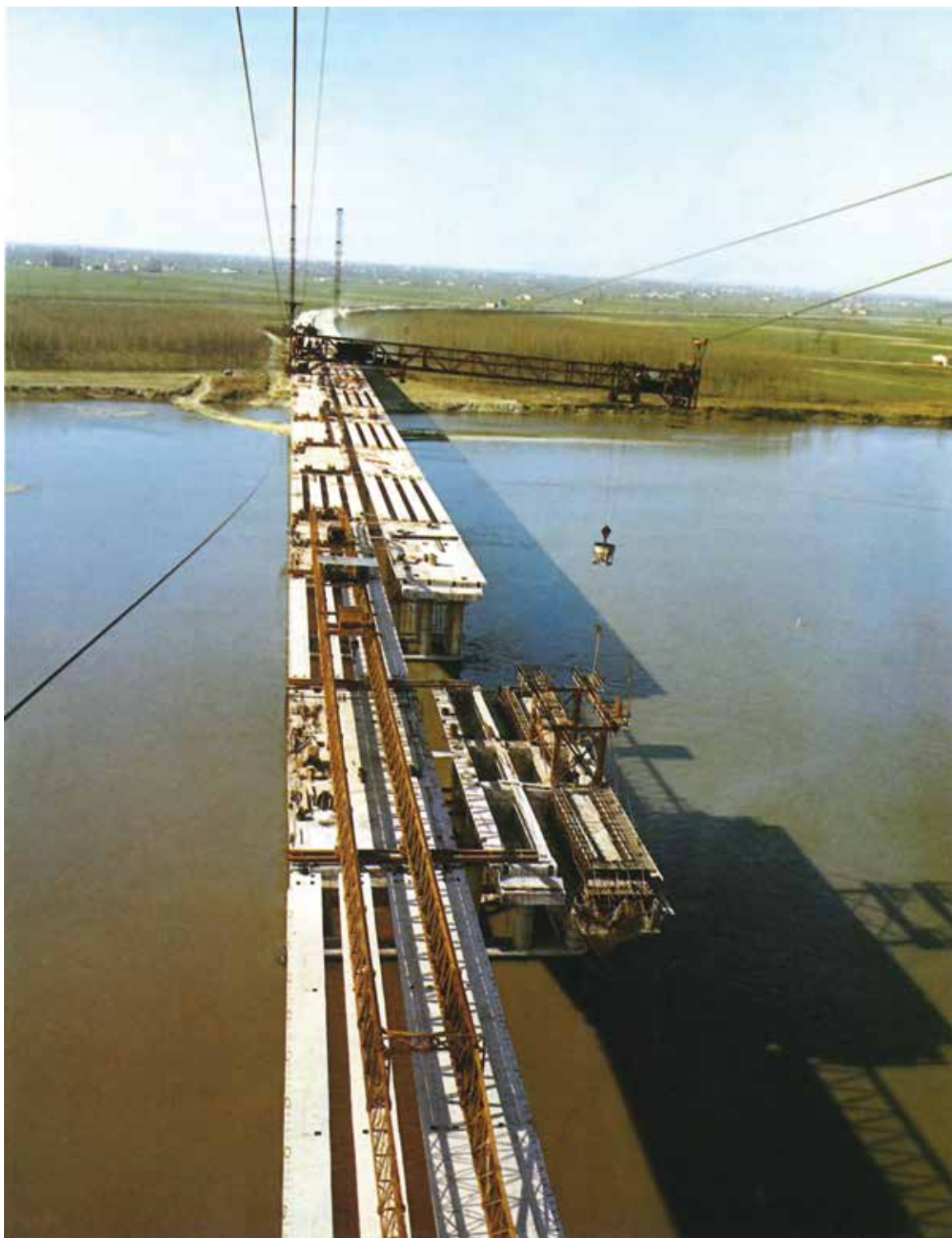
Ponte sul fiume Po: Il varo delle travi.
