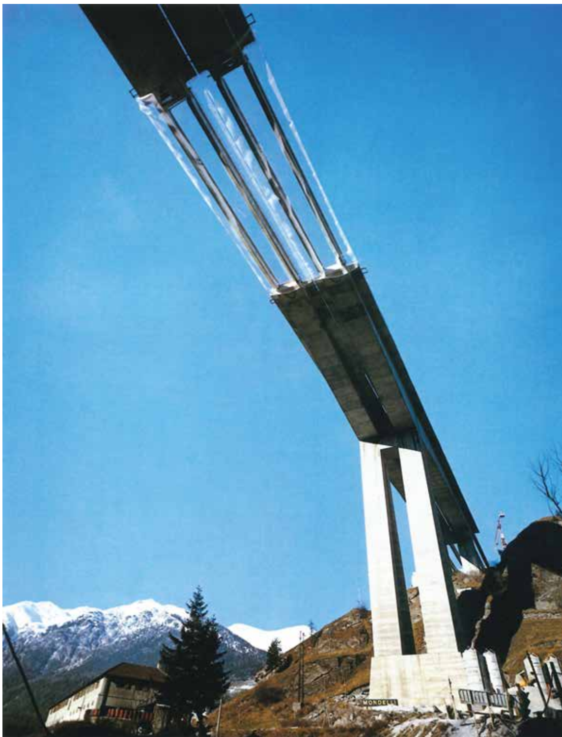
Viadotto Colle Isarco, campata centrale in costruzione.
