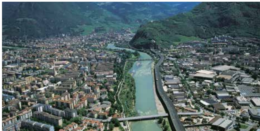
Il ponte autostradale sul fiume Po e l'attraversamento della città di Bolzano
