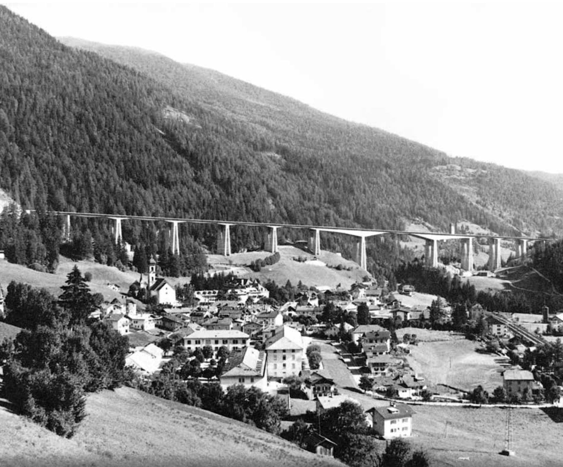
Viadotto Colle Isarco.
