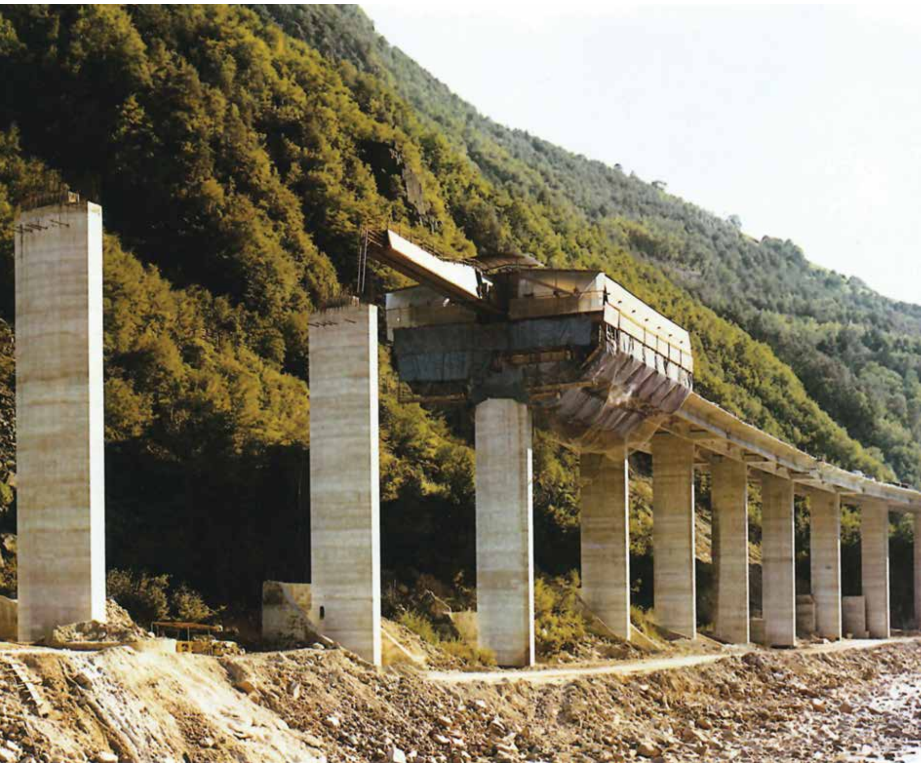
Chiusa-Bolzano: Viadotto Campodazzo in costruzione con centina mobile.
