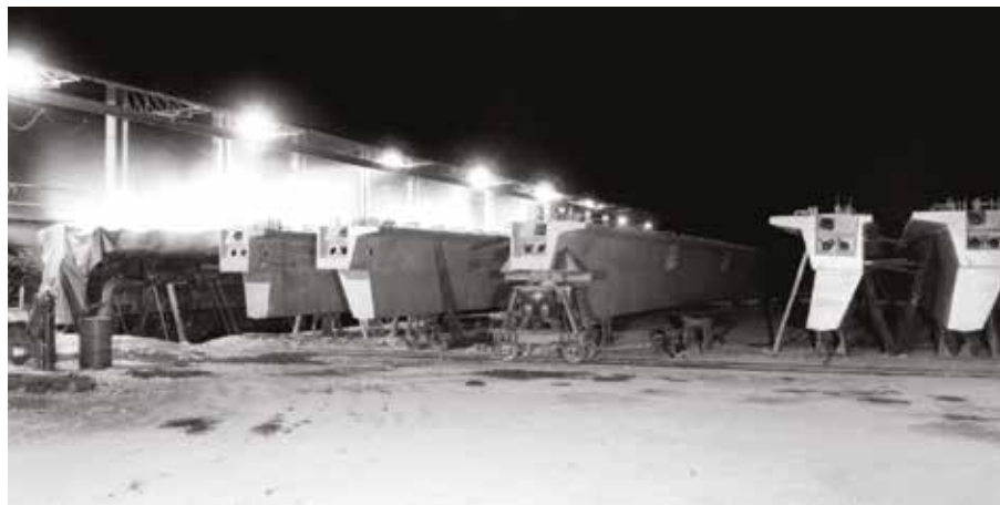
La costruzione del sedime autostradale nel tratto Rovereto Sud-Verona Nord nei pressi di Mori e la veduta notturna di un campo travi prefabbricate del viadotto Micheletti 2 nel tratto Chiusa-Bolzano Nord
