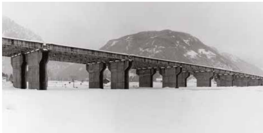
L'elevazione delle pile del viadotto Gries 2 nel tratto Chiusa-Bolzano Nord e una panoramica del viadotto Giovio in costruzione nei pressi di Vipiteno
